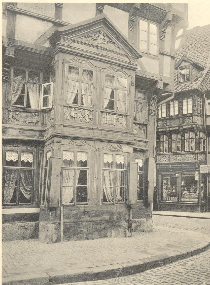
Links: Ecke Osterstrasse und Marktstrasse 24. Rechts Marktstrasse 21. Gotisches Haus mit jüngerem Erker (vor 1587). 1611.
