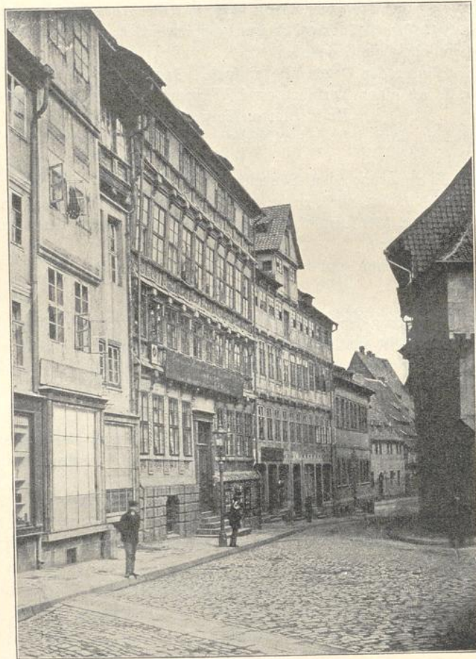
Fig. 224. Unterer Teil des Hohen Weges vor dem Umbau.
