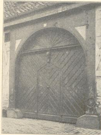
Fig. 354. Keßlerstraße 57. Einfahrtstor zur Loge.
