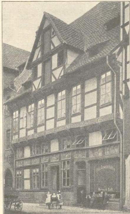
Fig. 330. Wollenweberstraße 23. Landsknechtshaus. Ansicht. 1554.
