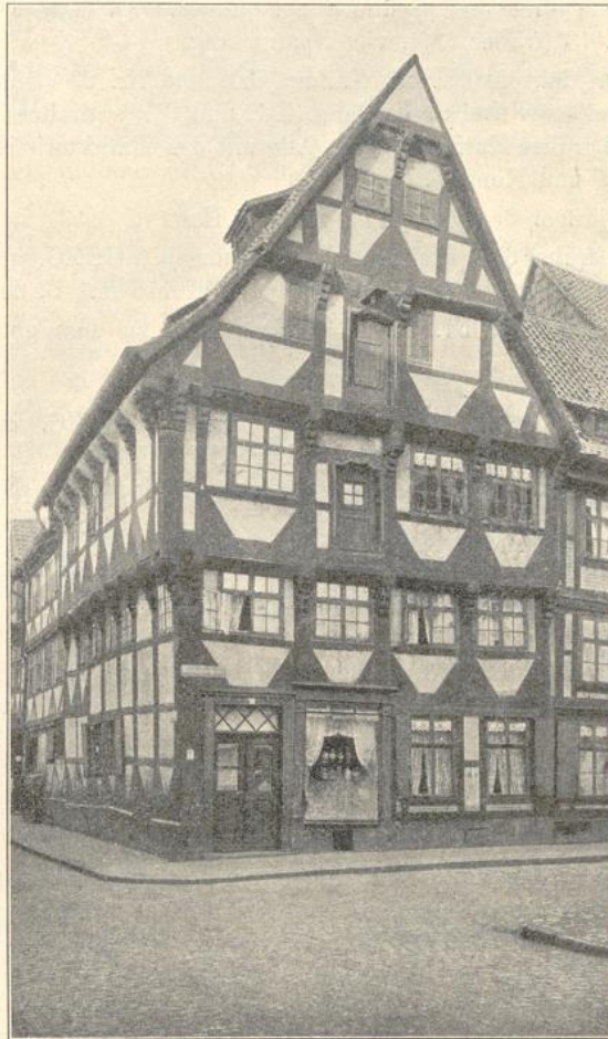
Fig. 346. Neustädter Markt 30. Ehemaliges Holzhaus.
