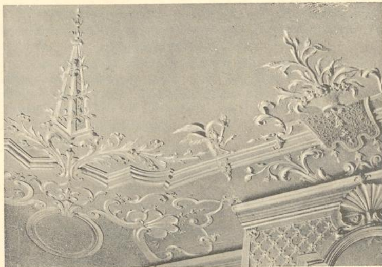
Fig. 266. Langer Hagen 21. (Ehem. von Zeppenfeld'sches Haus). Teil der Decke des Saales.
