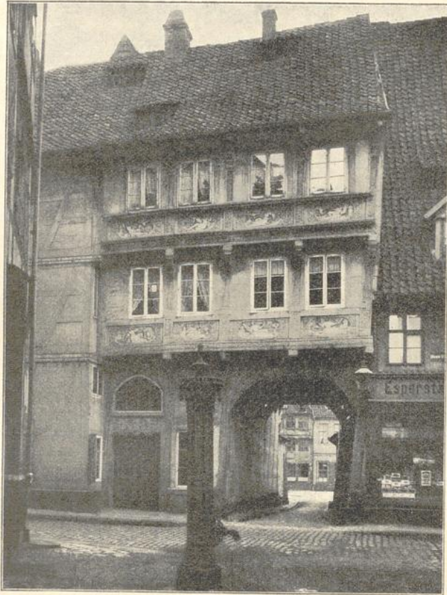
Fig. 296. Ehemaliger Zugang von der Dammstraße zur kleinen Venedig. 1621.
