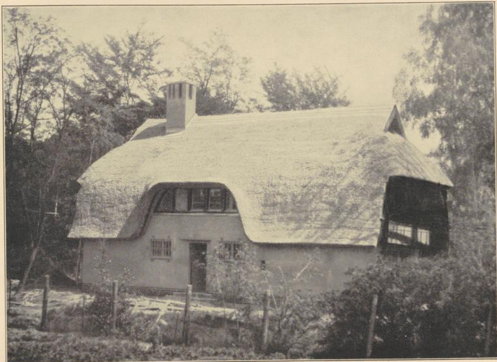
Landhaus in Ferch. Rohrdeckung.
