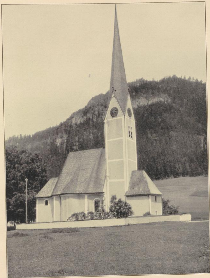
Kirche in Neuhaus. Schindelsdeckung.
