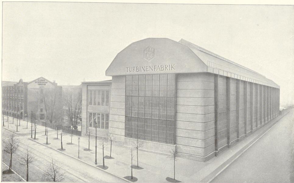
Abb. 154. Turbinenfabrik der A. E. G. in Berlin. Nach Abb. der Allgemeinen Elektrizitäts-Gesellschaft, Berlin.
