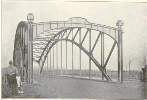
Abb. 102. Überführung der Bornumer Strasse über die Eisenbahn in Linden. 1905—06.
