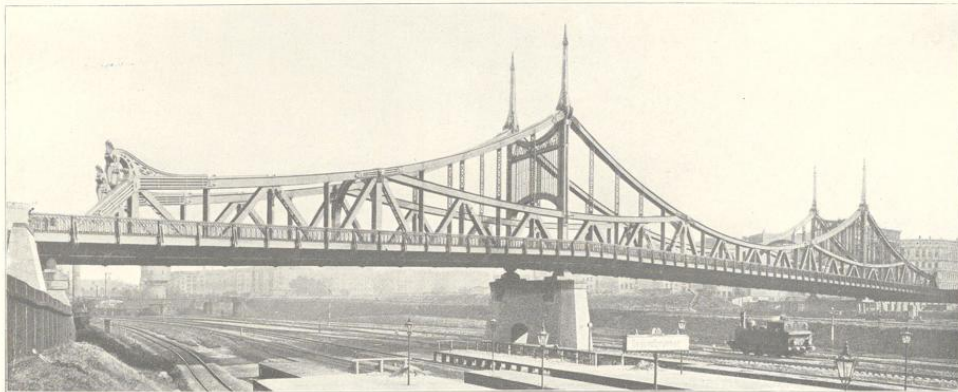
Abb. 37. Überführung der Swinemünder Straße über den Bahnhof Gesundbrunnen in Berlin. 1903-04. (Vergl. Abb. 34, 38.) Nach Abb. der Firma Beuchelt & Co., Grünberg i. Schls.
