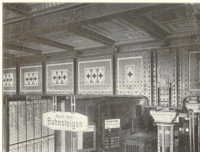
Abb. 218. Bemalte Blechträger über dem Personendurchgang des Hauptbahnhofs in Hannover. 1910—11.
