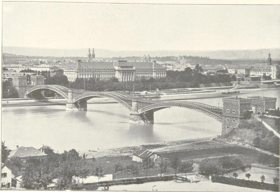
Abb. 48. Ältere Rheinbrücke bei Coblenz. 1862—64.
