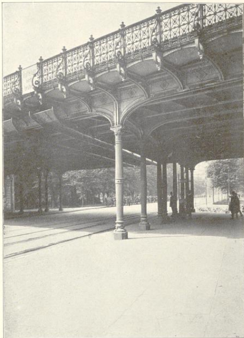
Abb. 98. Pendelstütze der Berliner Stadtbahn. 1880.
