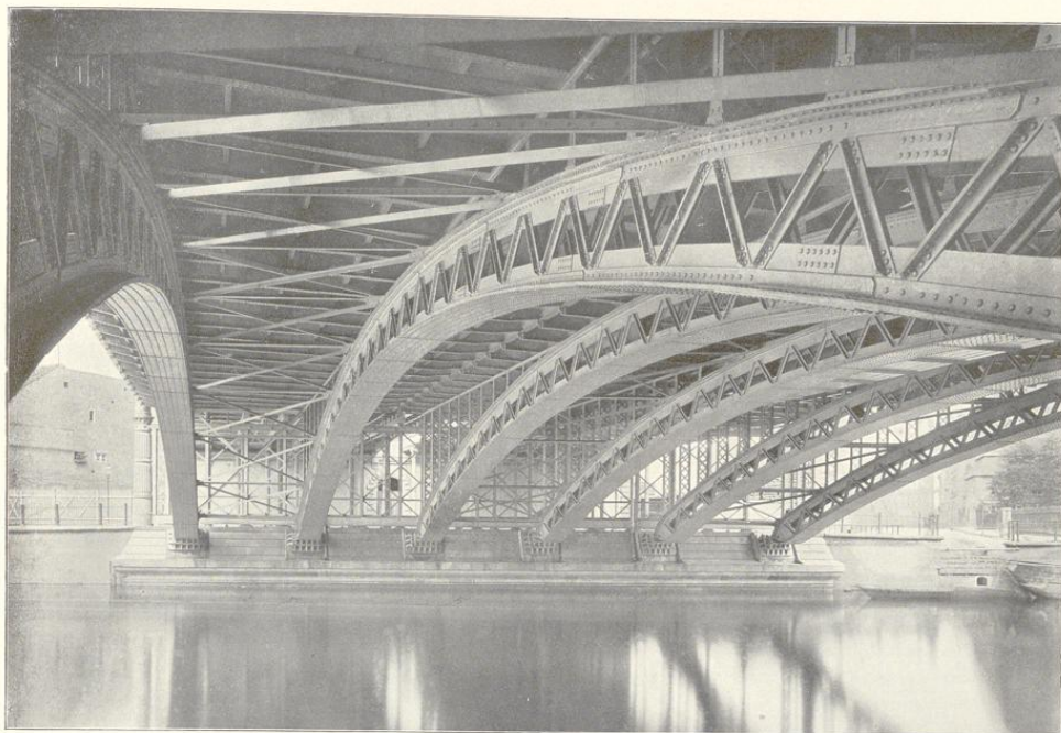
Abb. 50. Untersicht der Spreebrücke am Schiffbauerdamm. 1879—81. Nach: „Rückwardt, Bauwerke der Berliner Stadteisenbahn“, 1874—82.
