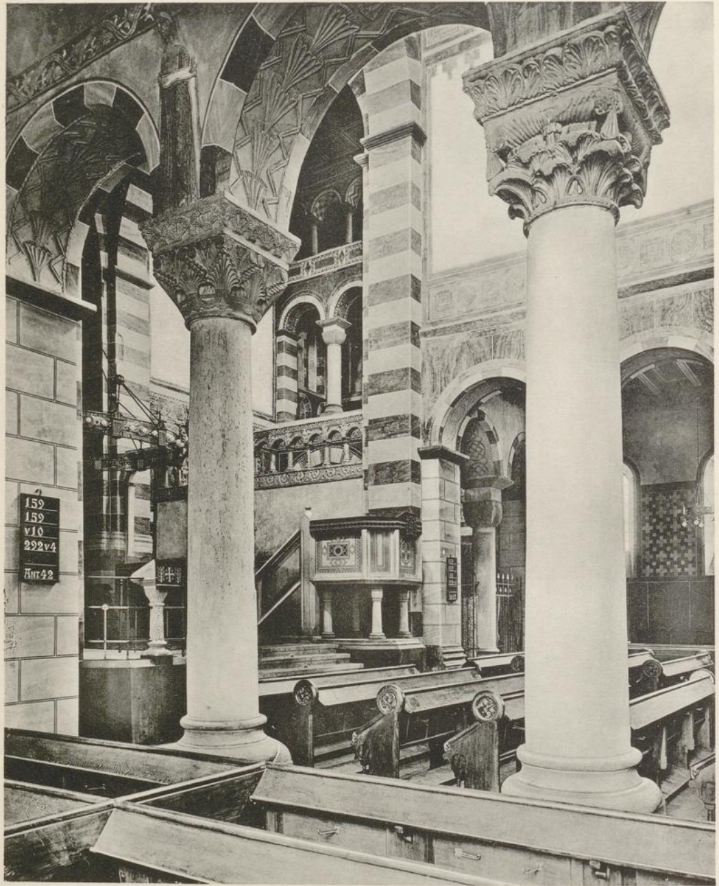
Hildesheim. St. Michael. Blick nach dem nördlichen Querhaus. Fig. 146.
