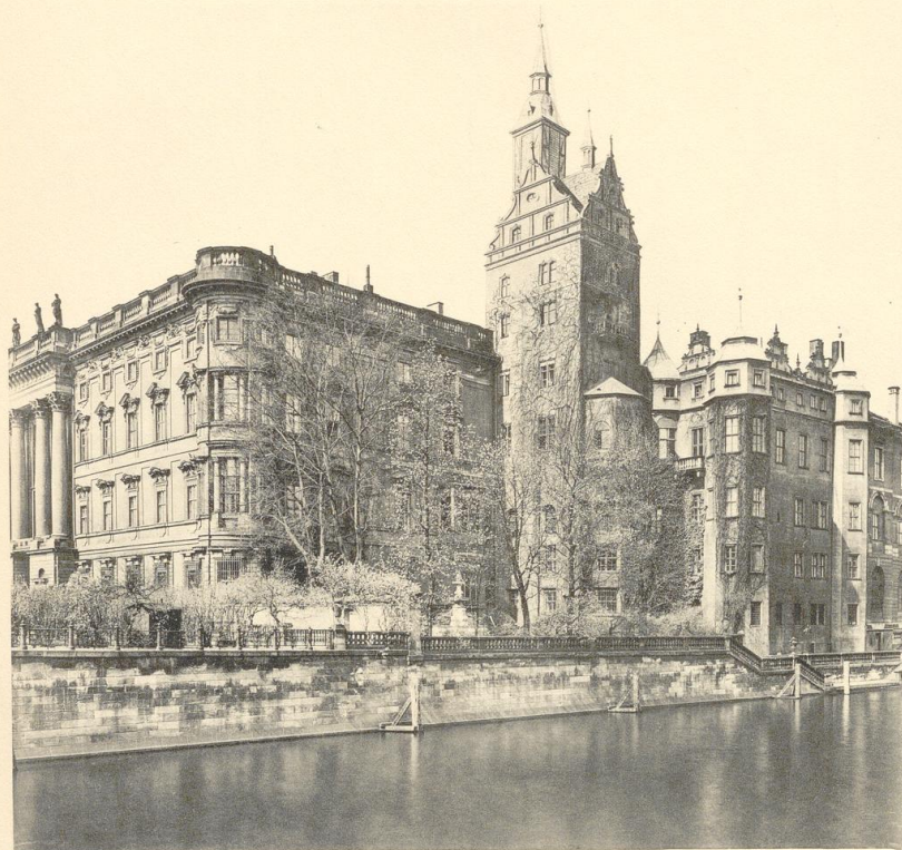
33. Teilansicht der Spreefront des Schlosses mit Ergänzung der abgebrochenen Endigung des Kapellenturms
