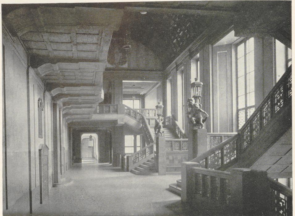
Treppenaufgang Justizgebäude (Arch. Staatl. Hochbauverwaltung)
