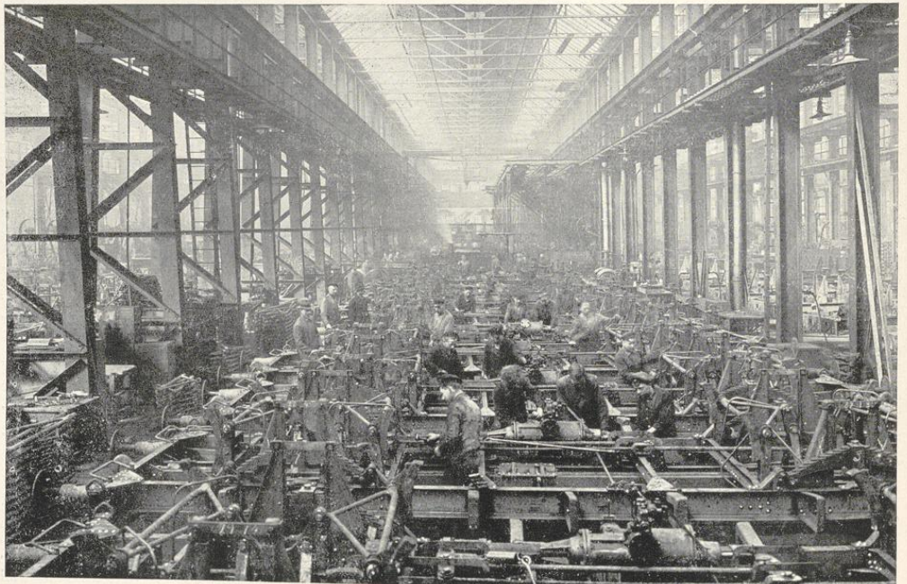
Abb. 8. Teilansicht aus dem Wagenbau. Einbau der Luftdruckbremse in das Untergestell
