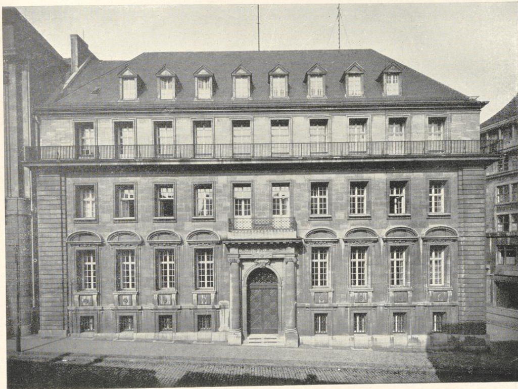
Geschäftshaus der Filiale Essen, Lindenallee 4
