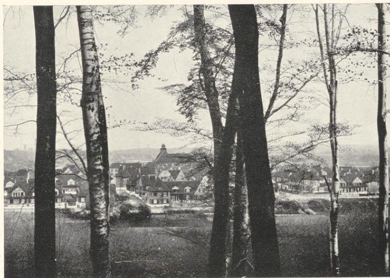
Bergmannsiedlung Gottfried-Wilhelm (Arch. O. Schwer †)
