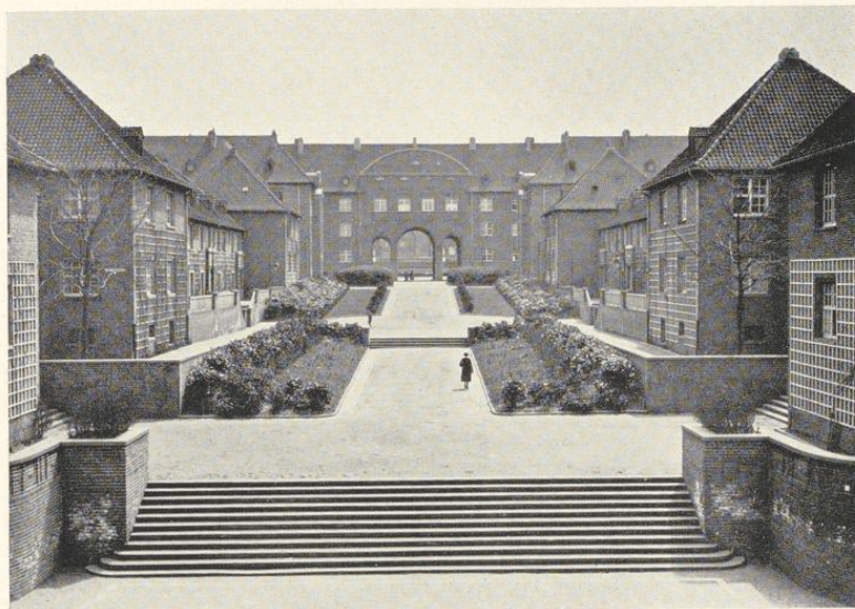
Kruppsche Siedlung Alfredshof, Hochbauteil
