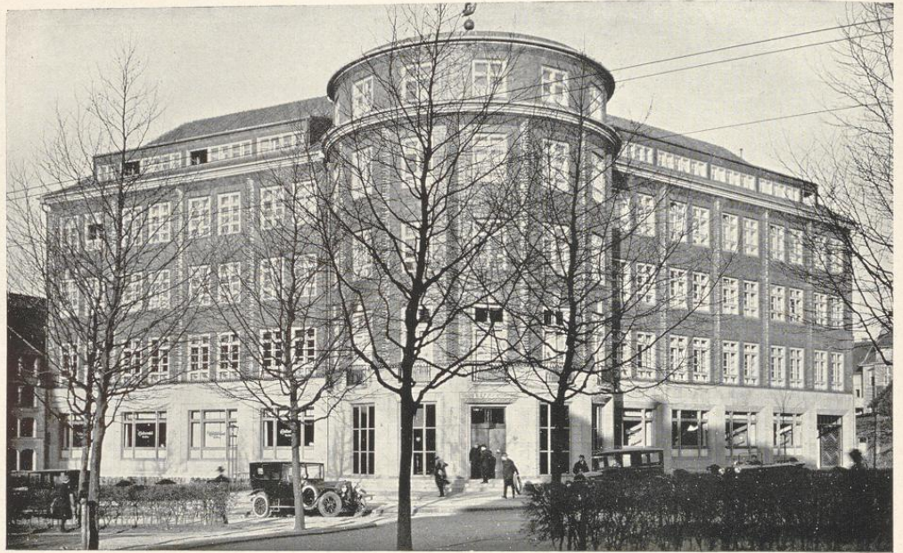
Bürohaus „Erzhof“ Essen, Gesamtansicht
