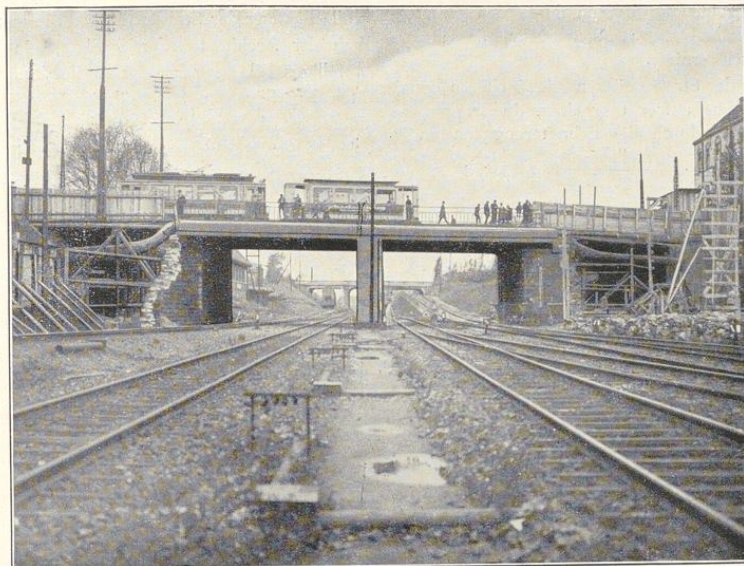
Abb. 1. Rüttenscheider Brücke. Beginn des Umbaus
