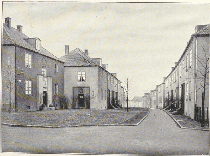
Abb. 3. Straßensbild der Siedlung Feldhaushof
