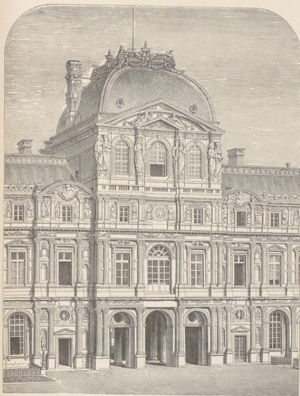
1. Westlicher Pavillon des Louvre. Hoffassade, Von Pierre Lescot. (Um 1560.)
