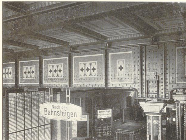
Abb. 218. Bemalte Blechträger über dem Personendurchgang des Hauptbahnhofs in Hannover. 1910—11.
