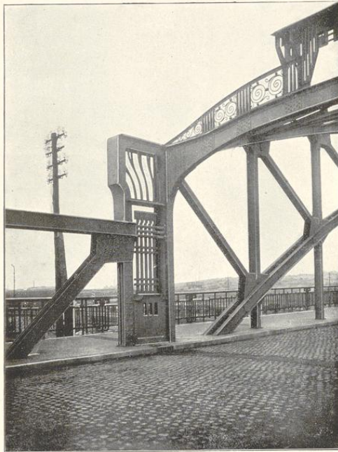
Abb. 103. Überführung der Nenndorfer Straße über die Eisenbahn in Linden. 1906—08.
