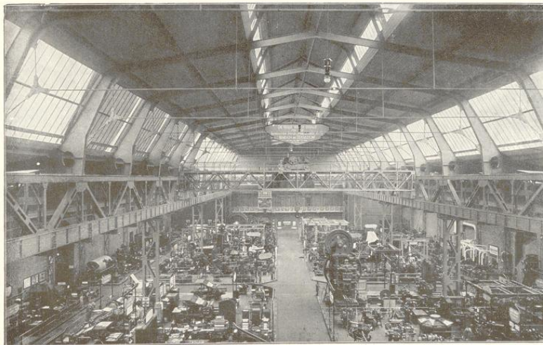
Abb. 168. Deutsche Hauptmaschinenhalle der Brüsseler Weltausstellung. 1910. Nach: „Der Eisenbau“, 1911, S. 78. Verlag Wilhelm Engelmann, Leipzig.
