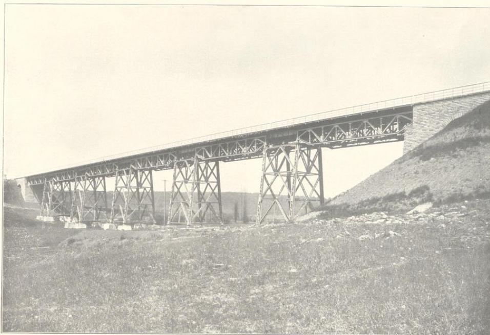
Abb. 15. Villersbach-Viadukt in Lothringen. 1907—08. Nach Abb. der Akt.-Ges. Union in Dortmund.
