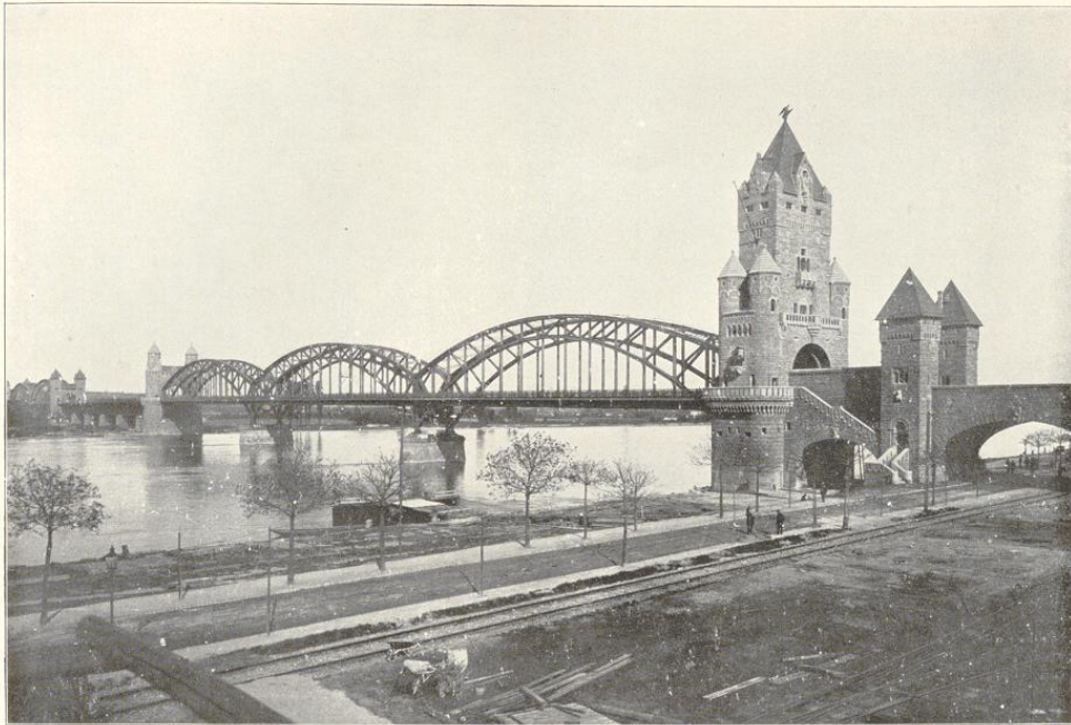
Abb. 73. Kaiserbrücke über den Rhein bei Mainz. 1902—03. Nach Abb. der Maschinenfabrik Augsburg-Nürnberg, A.-G., Werk Gustavsburg.
