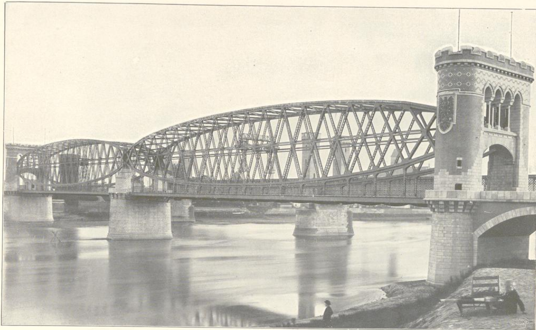
Abb. 14. Neue Eisenbahnbrücke bei Marienburg. 1889—91. Nach Abb. der Akt.-Ges. Harkort in Duisburg a. Rh.
