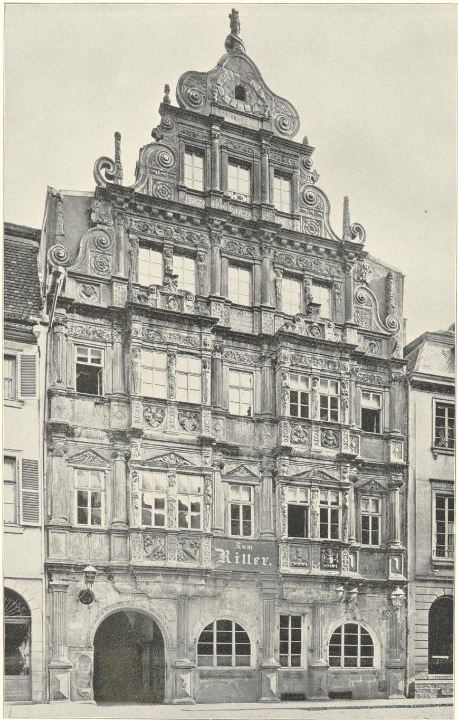
Heidelberg. Das Haus zum Ritter. 1592. Vor der Renovierung
