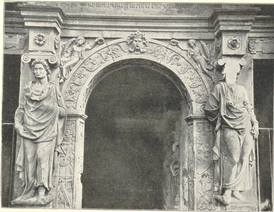
Heidelberg. Otto-Heinrichsbau. Detail des Portals
