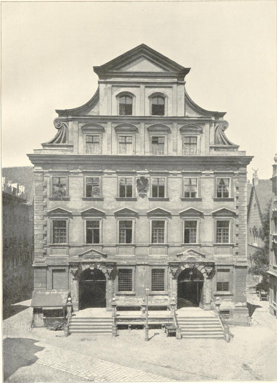
Augsburg. Metzgerhaus. Erbaut 1609 von Elias Holl
