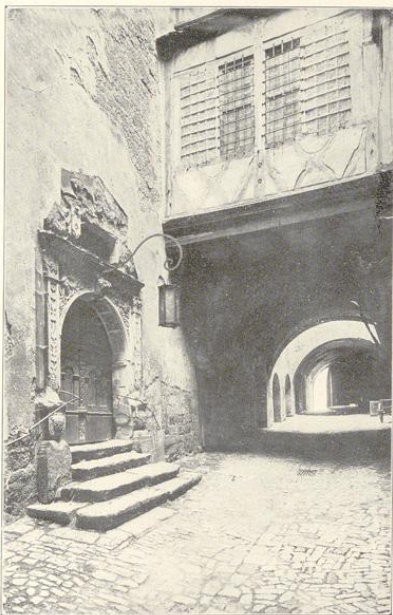
Portal im Rathaushof
