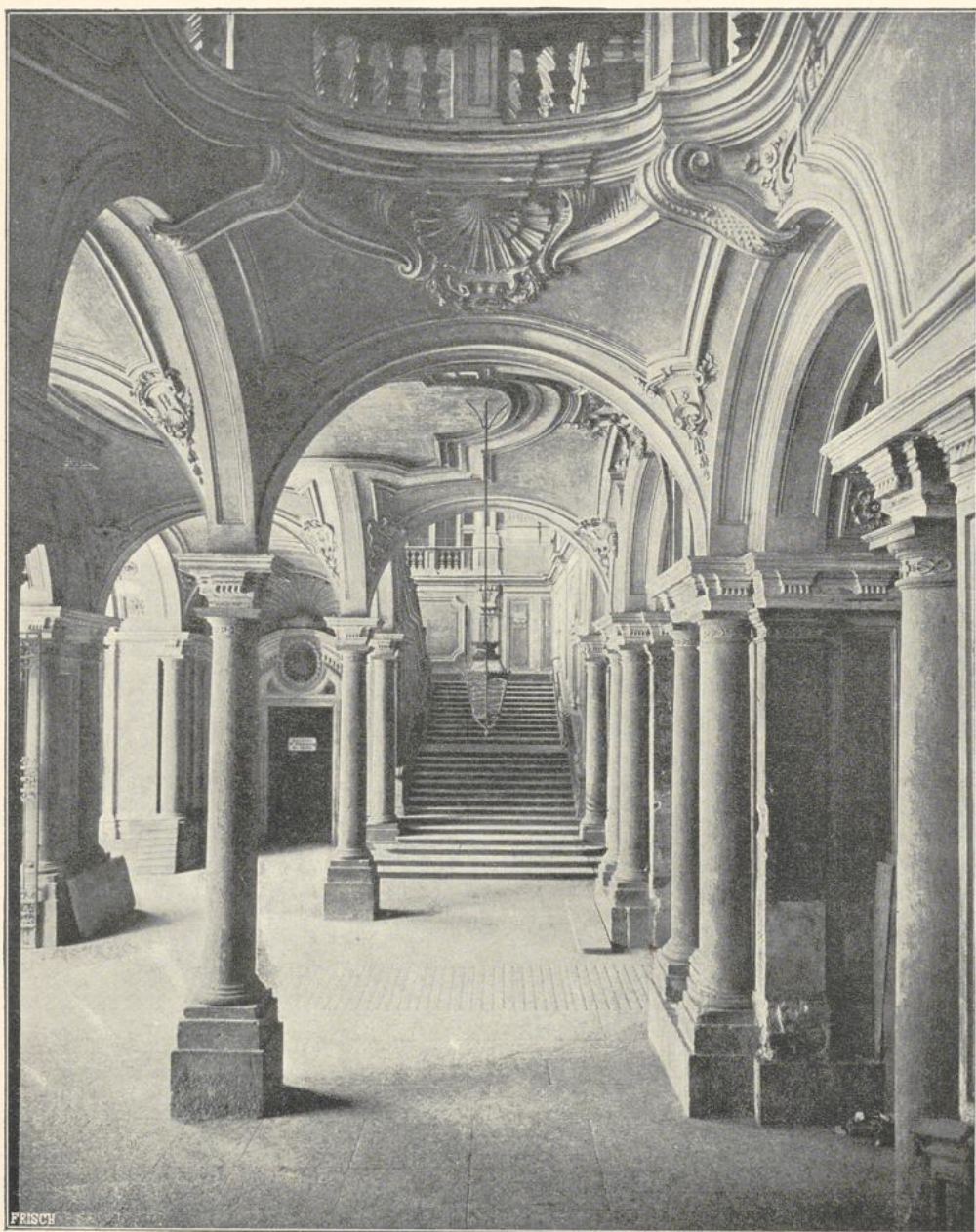
61. Vestibül und Treppe im Palazzo Madama zu Turin.
