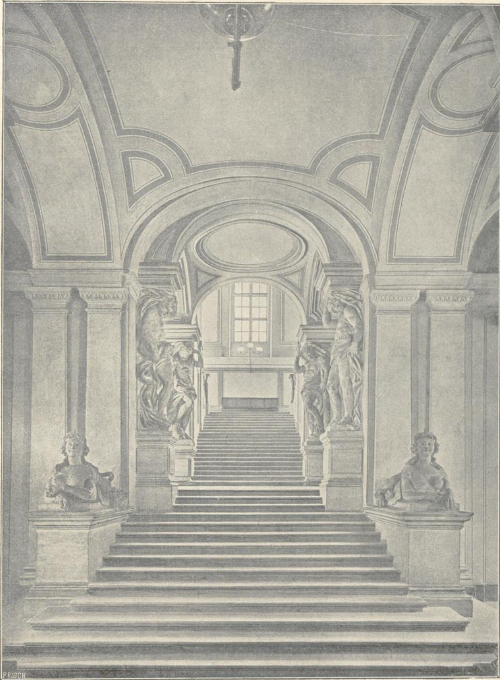
82. Haupttreppe im ehemal. Palast Trautson zu Wien. (Nach R. Döhme, Barock- und Rokoko-Architektur).
