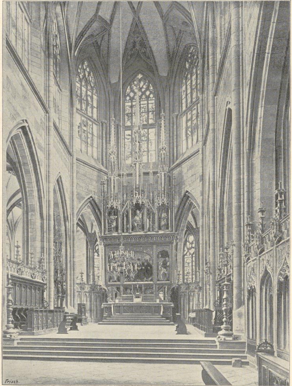
109. Inneres des Chors im Münster zu Freiburg i. Br. (Nach einer Photographie).
