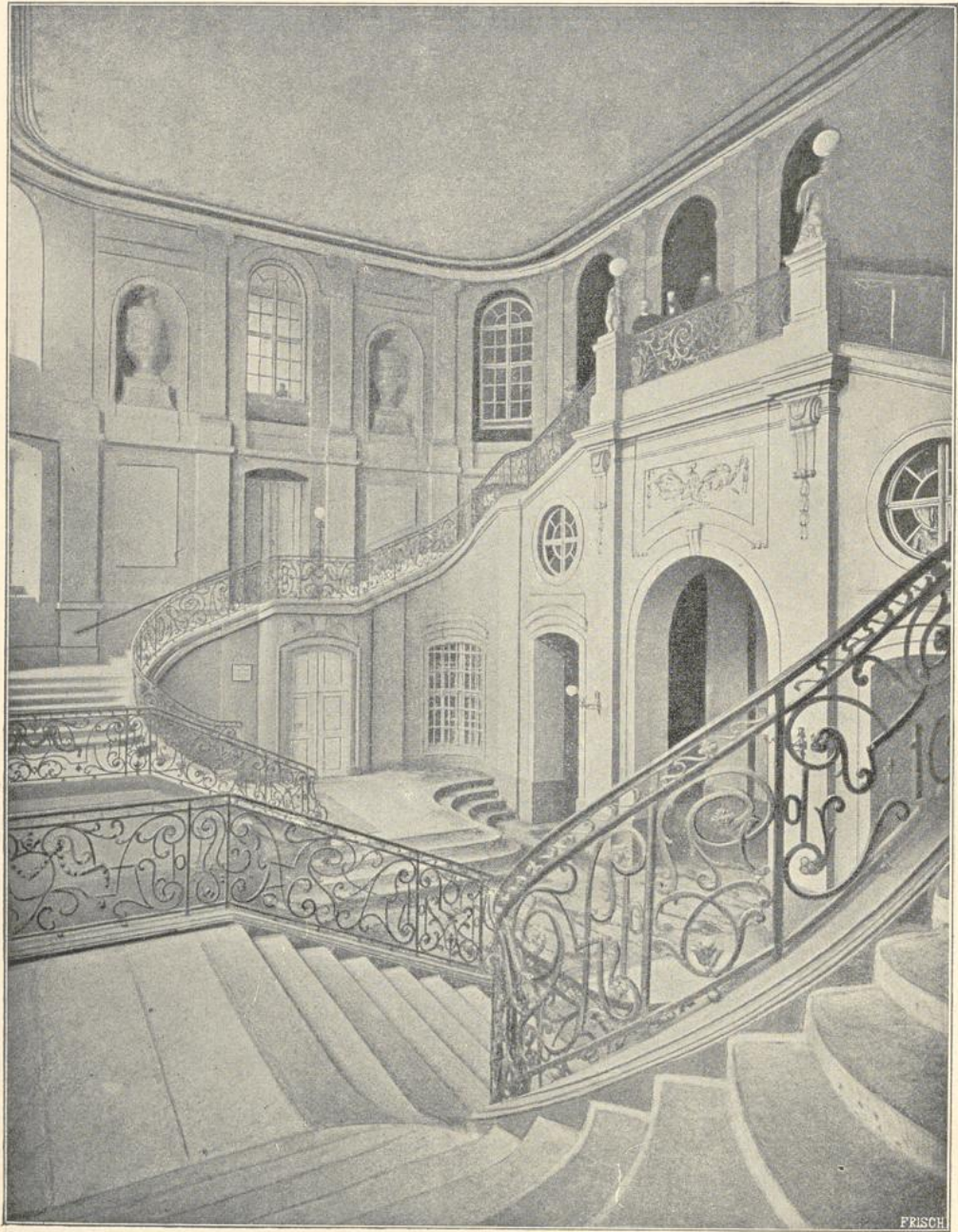
76. Treppe im Landhause in Dresden. (Nach Blätter für Architektur und Kunsthandwerk).
