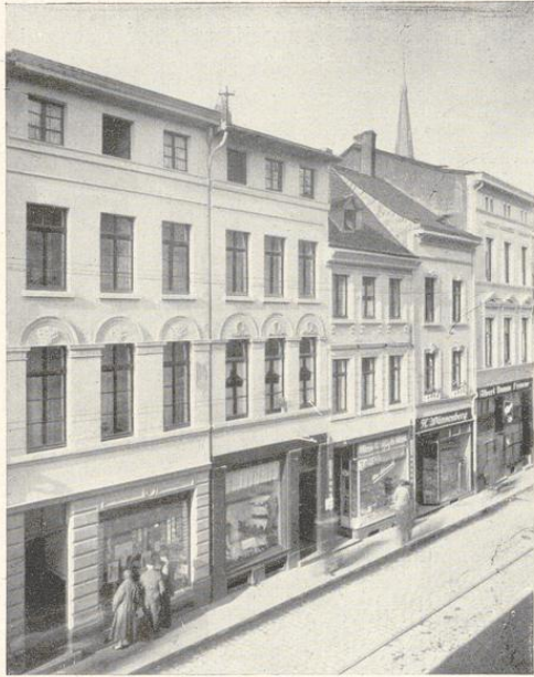
Klassizistische Fassade an der Poststr. Fot. Hesse, Duisburg.
