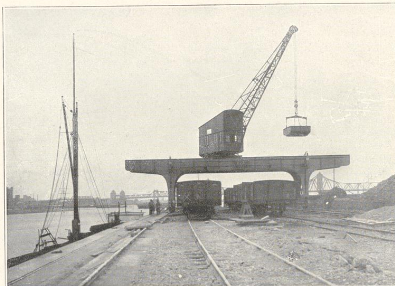
Portalkran an der Kaimauer des Hafkanals
