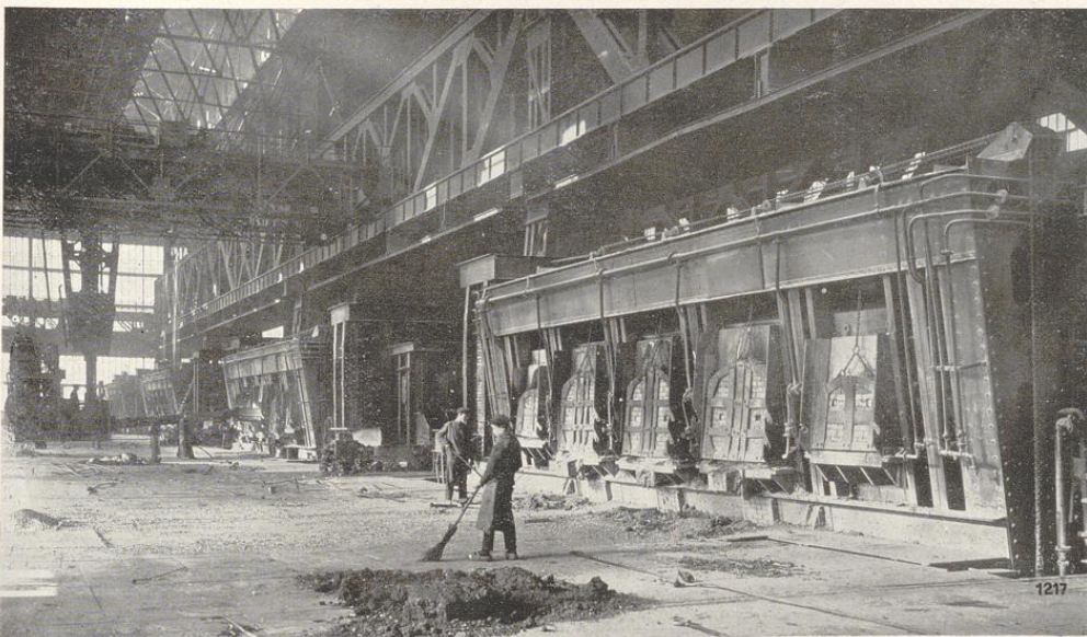
Ofenbühne im Martinstahlwerk.
