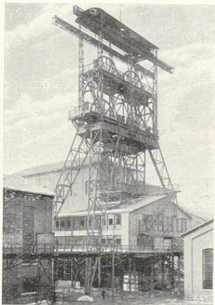
Fördergerüst nebst Schachtgebäude und Verbindungsbrücke.
