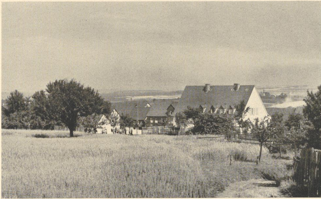
Einklassige Schule in Frankweiler, Regierungsbezirk Koblenz. Architekt: Kreisbaumeister Peitz, Simmern. Oben: Blick von Süden auf das sich in Landschaft und Ortsbild gut einfügende Schulgebäude. Unten: Blick von Südosten auf den Wohnteil und Grundriß. M. 1:300.
