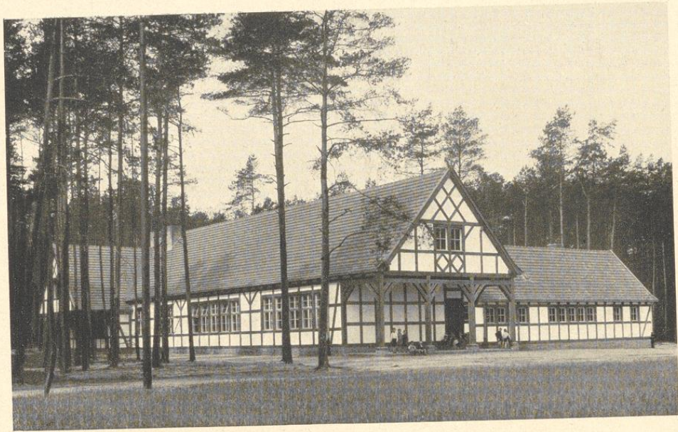
Zweiklassige Waldschule in Treuenbrietzen-Frohnsdorf. Architekt: Sepp Scherer, Berlin. Oben: Blick auf den Schülereingang. Links die Vorlaube der Lehrerwohnung, rechts das Badehaus. Unten: Erdgeschoß. M. 1:400. Die Schule liegt in einer Siedlung, sie erfaßt die drei untersten Jahrgänge. Die Lage im Walde legte es nahe, hier einen Fachwerkbau aufzuführen. In dieser Bauweise ließen sich die Vorlauben und die lange offene Halle zwanglos und schön dem Baukörper anfügen. Solche Hallen sind nicht nur eine architektonische Bereicherung, sondern sie sind auch gerade für Schulen sehr zweckmäßig als Unterstand bei schlechtem Wetter. Das Bad steht auch den Bewohnern der Siedlung zur Verfügung.
