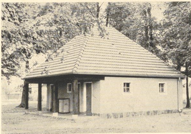
Oben: Einzelheiten des Haupteinganges. Links: Das Abortgebäude, ein Beispiel dafür, wie man einem solchen Häuschen durch eine einfache Vorhalle nach ländlicher Art und durch gut geschnittene Fenster seine oft peinliche Gegenständlichkeit nehmen kann.
