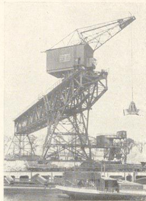
Erzverladebrücke, 74 m Spannweite mit Erzhreher und Greiferdrehkran, 20 t Tragkraft, 14 m Ausladung, am Erzlager der Rheinischen Stahlwerke im Nordhafen der Duisburg-Ruhrorter Häfen.
