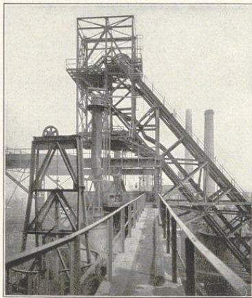
Neuzeitliche Hochofenbeschickungsanlage durch Schrägaufzug Kuppers-Tigler der Rheinischen Stahlwerke in Duisburg-Meiderich
