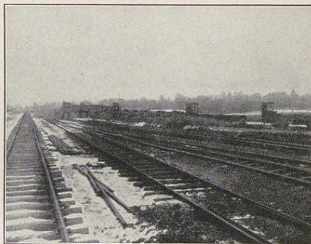
Ausbau des Bahnhofes Kiel-West
