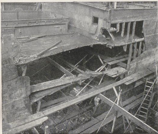
Abb. 3. Autogen unter Wasser ausgeschnittenes Leck der „Skandia“ nach Abnehmen der Leckdichtung im Dock
