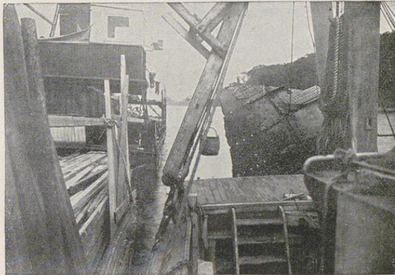
Abb. 2. Autogen unter Wasser ausgeschnittenes Schiffswandstück
