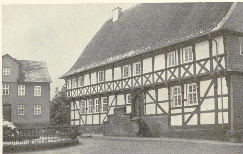
Abb. 56. Rathaus in Zierenberg (ältestes Fachwerkhaus in Hessen; erbaut 1450); durch Zimmermeister B. d. Z. Eckhardt-Kassel wiederhergestellt.
