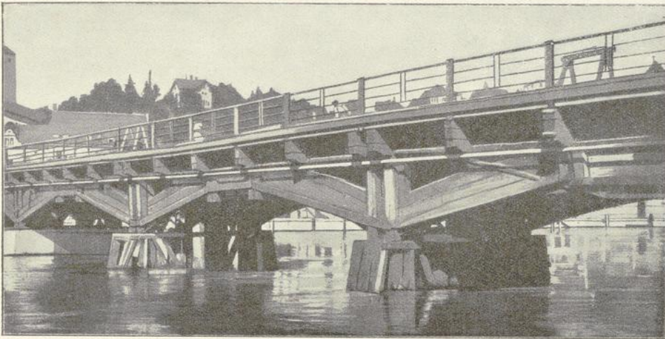
Abb. 69. Alte Holzbrücke in Schaffhausen a. Rh. (Aus „Der deutsche Zimmermeister“, Jahrg. 1926, Nr. 33.)
