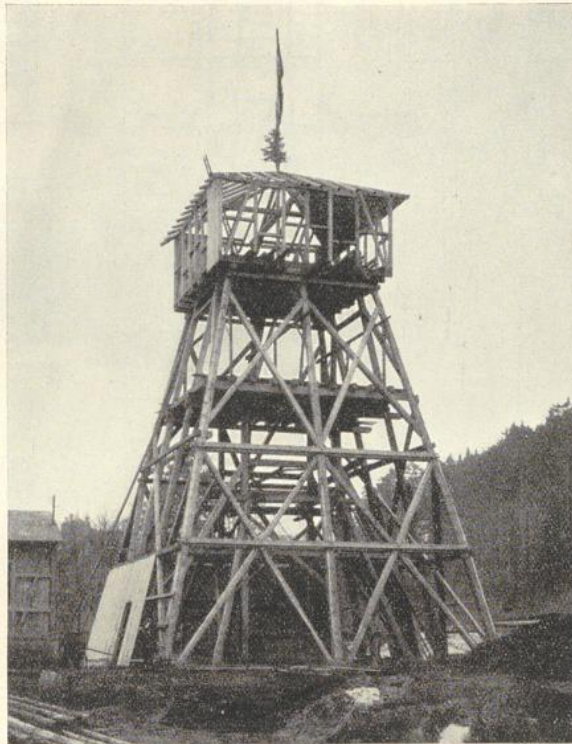
Abb. 120. Förderturm für die Zeche Drusel. Ausgeführt von Zimmermeister B. d. Z. H. Eckhardt, Kassel.
