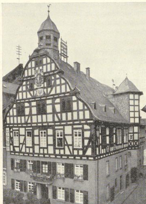
Abb. 54. Rathaus in Butzbach (Hessen, 1560 erbaut); Fachwerk 1927 freigelegt durch Zimmermeister B. d. Z. Euler-Butzbach.
