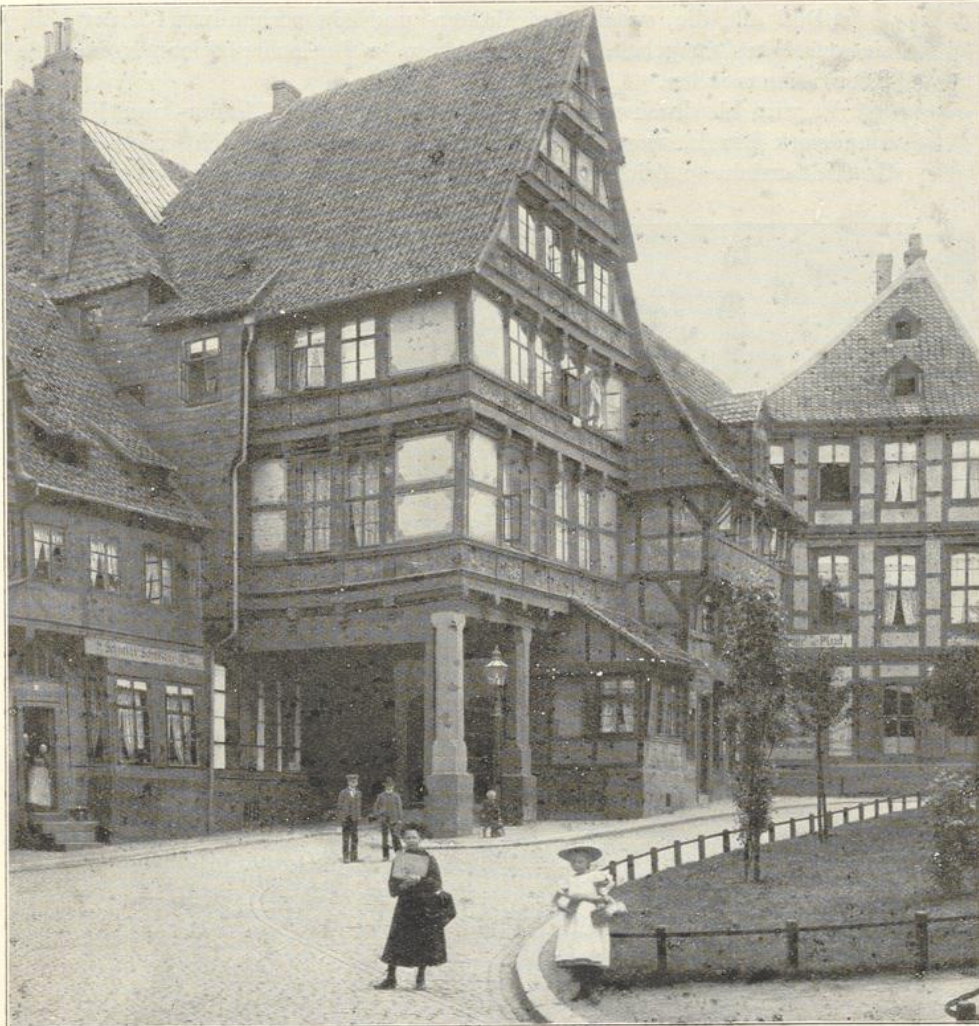
Abb. 67. Pfeilerhaus in Hildesheim.
