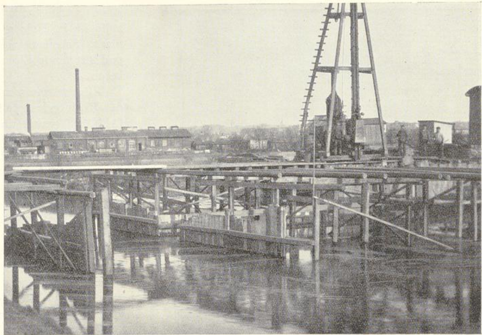
Abb. 140. Dükerverlegung durch einen Kanal. Ausführung des Gerüstbaues: Zimmermeister B. d. Z. H. C. Böge, Hamburg.
