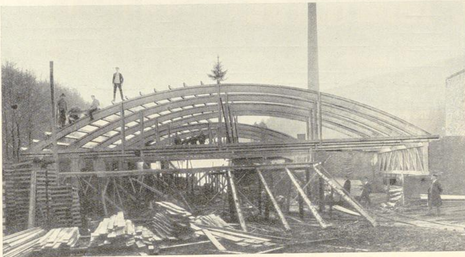
Abb. 89. Dachkonstruktion für ein Sägewerk in Abentheuer. Ausgeführt: Zimmermeister B. d. Z. Eduard Kunz, Birkenfeld.
