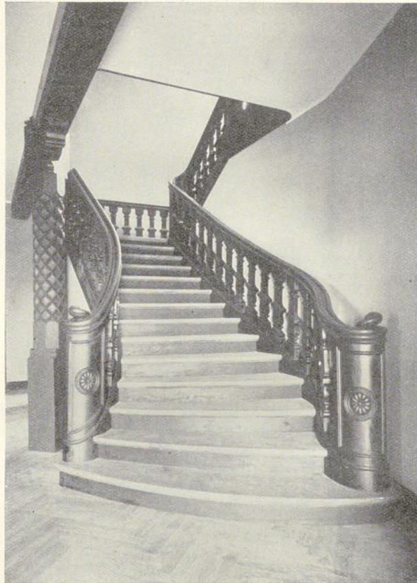
Abb. 185. Treppe im Hause Ambs in Freiburg i. Br. Ausgeführt: Zimmermeister B. d. Z. Stadtrat Franz Ambs, Freiburg i. Br.
