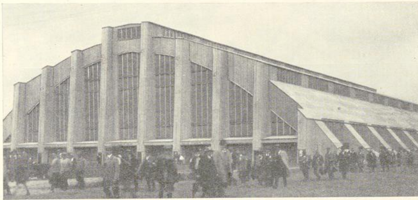
Abb. 103. Sängerhalle in Dresden. Bearbeitet und ausgeführt: Zimmermeister B. d. Z. Ernst Noack, Dresden.
