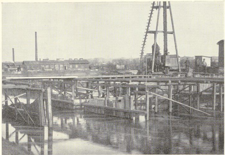
Abb. 140. Dükerverlegung durch einen Kanal. Ausführung des Gerüstbaues: Zimmermeister B. d. Z. H. C. Böge, Hamburg.
