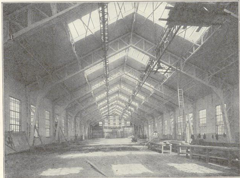
Abb. 164. Hallenbau in Holzbau System „Meltzer“. Flugzeugfabrikationshalle Siemens-Schuckert-Werke, Nürnberg.
