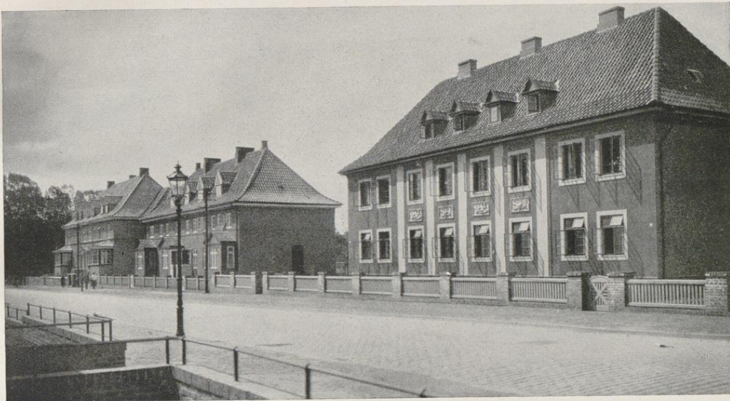
Wohnhäuser an der Gellerstraße — Phot. Petersen Erbaut von der Heimstätte Schleswig-Holstein, Leitung Dr.-Ing. Grabbe
