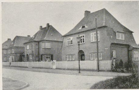
Wohnhäuser an der Hansastraße — Phot. Petersen
