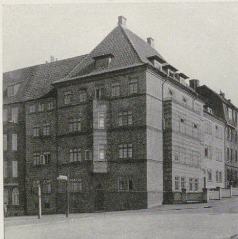
Städt. Wohnhaus in Neumühlen — Phot. Petersen Hochbau- und Siedlungsamt Dr.-Ing. Hahn
