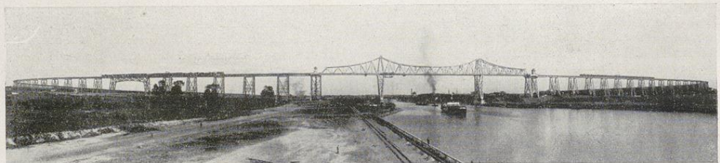
Kaiser-Wilhelm-Kanal, Rendsburger Hochbrücke — Phot. Kanalamt
