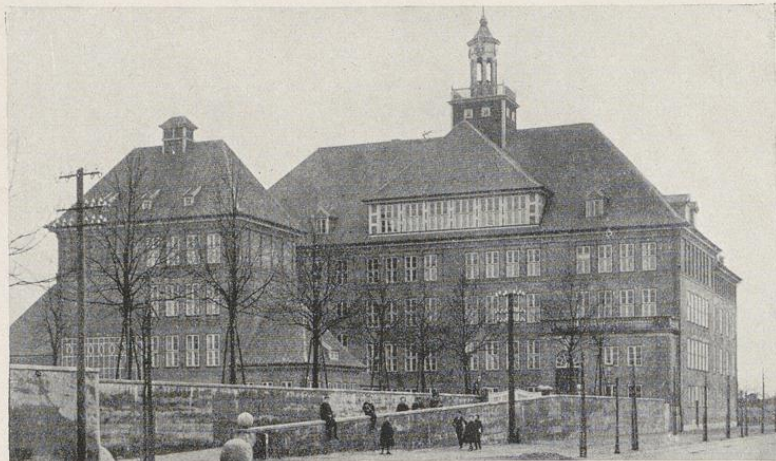
Schule am Winterbecker Weg — Städt. Hochbauamt
