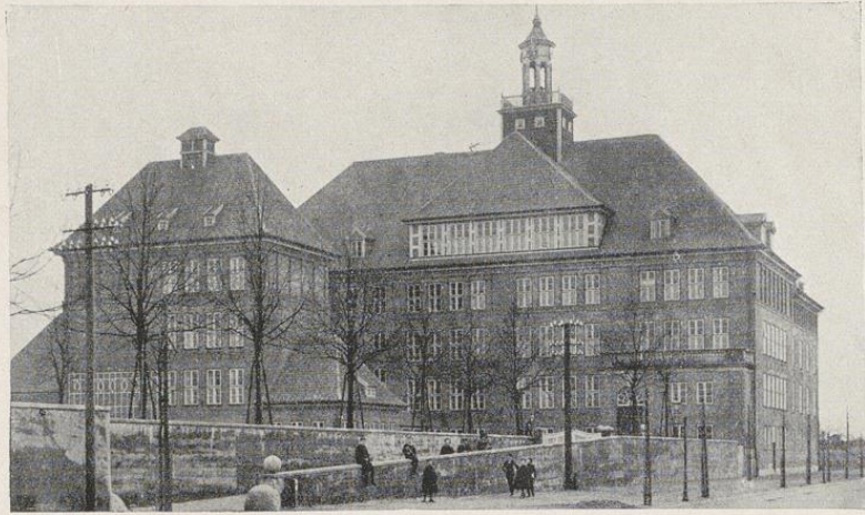
Schule am Winterbecker Weg — Städt. Hochbauamt
