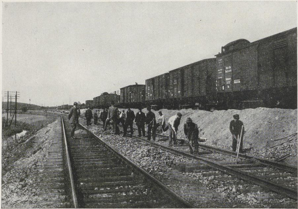
Gleisumbau Strecke Kiel-Altona
