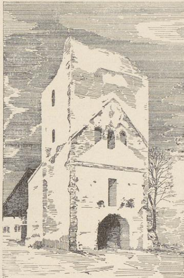
Kirch-Thurm beim Abbruch.
