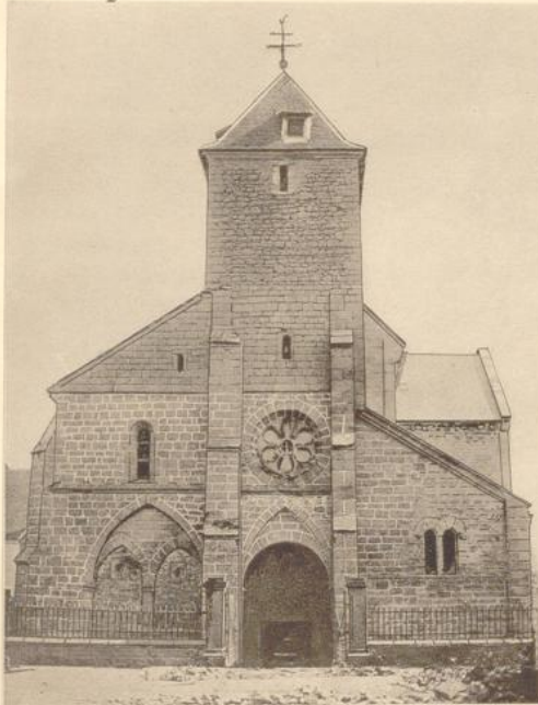
Äußere Ansicht gegen Westen.
