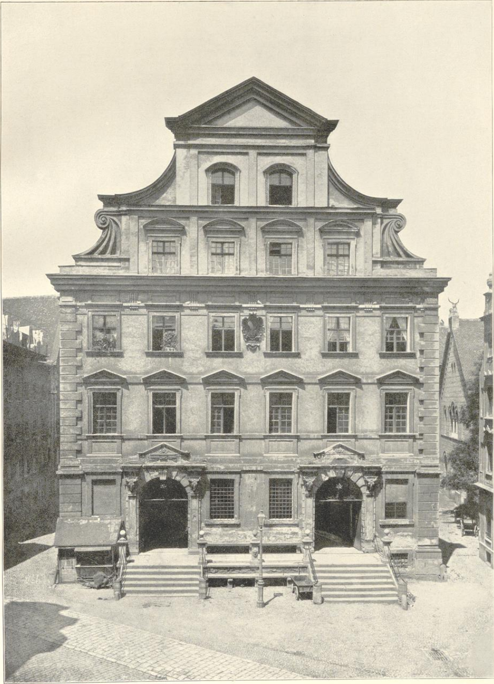
Augsburg. Metzgerhaus. Erbaut 1609 von Elias Holl
