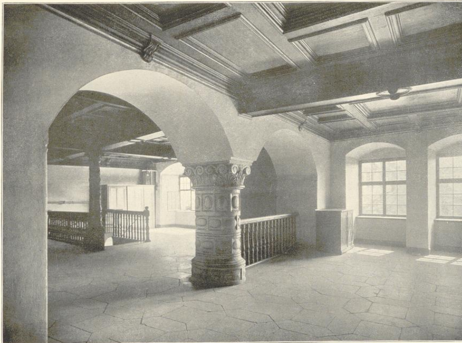
Ulm a. D. Obergeschoss im „Neuen Bau“ 1583–1603
