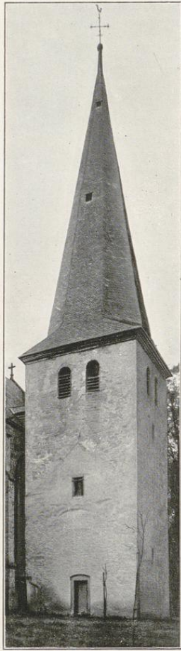
Nordostansicht des Kirchturmes.
