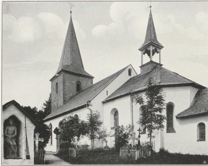
Südostansicht der Kirche.
