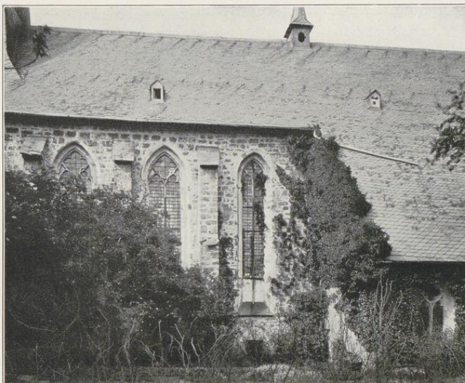
Teil der Südseite.
