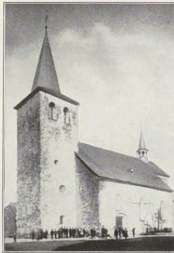
Pfarrkirche von Südwesten, nach Aufnahme von Grobbel, Fredeburg.
