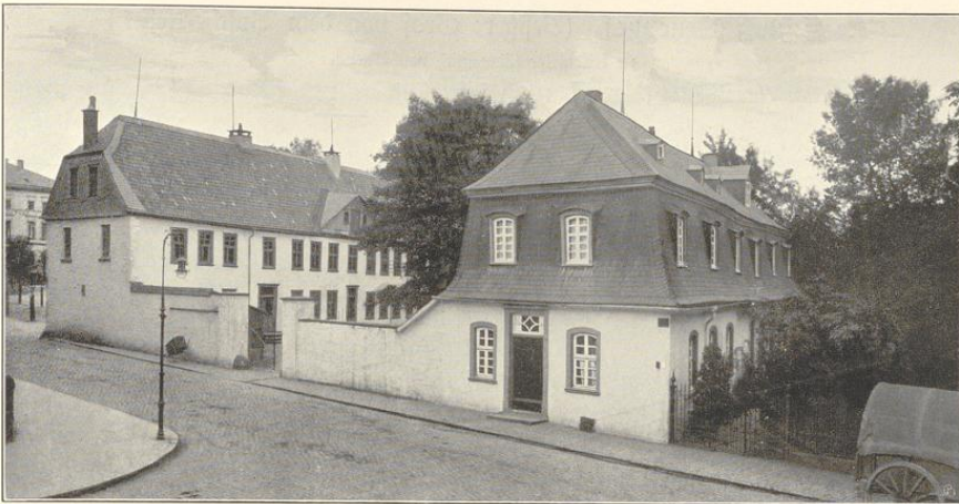
Südanficht des Hauses Knapperstraße 2.
